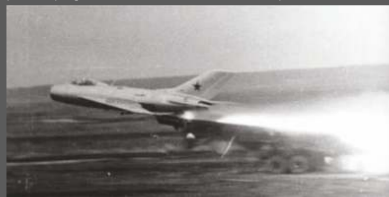
2 Il MiG-19 SM-30 con il quale i sovietici esplorarono il concetto del decollo a lunghezza zero.
